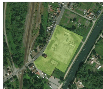
Ancienne centrale EDF (friche SNCF) Abbeville 2 ha – 0,65 MWc installable Google Satellite
